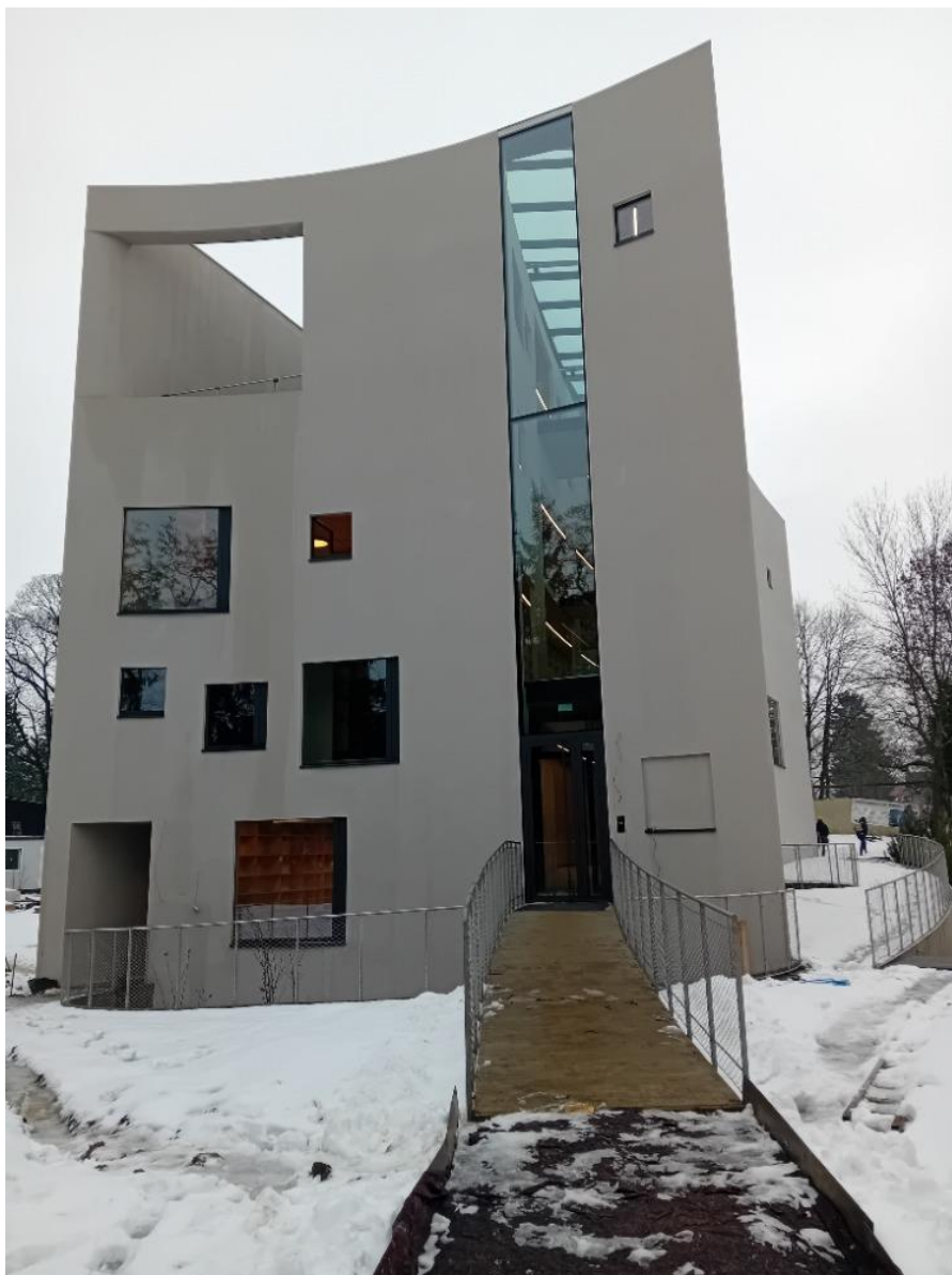
Výstavba nové budovy knihovny ve Skálově ulici. Foto: Jaroslav Kříž.
